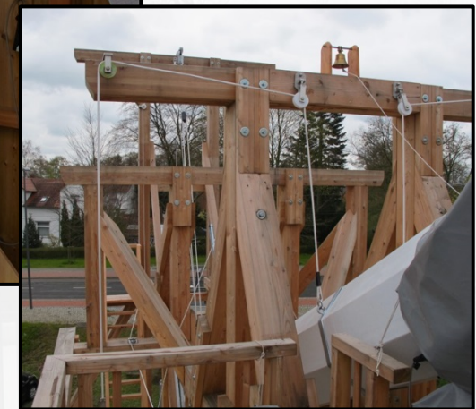
Blick in das „Maschinenwerk“
