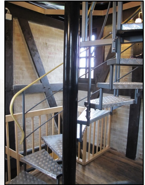
Nachgeführte Wendeltreppe im Innern des Turmes
